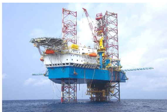
ジャッキアップ型リグ 「HAKURYU-10」
