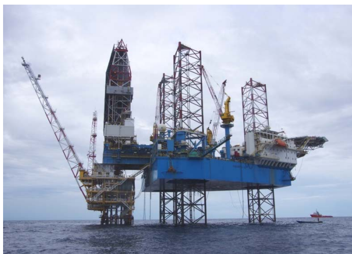
ジャッキアップ型リグ 「HAKURYU-10」
