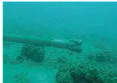
父島工事における掘管のパンチアウト状況
