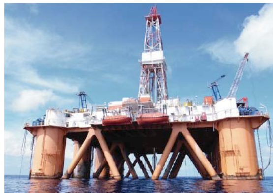
マレーシア沖で稼働中のNAGA 1
