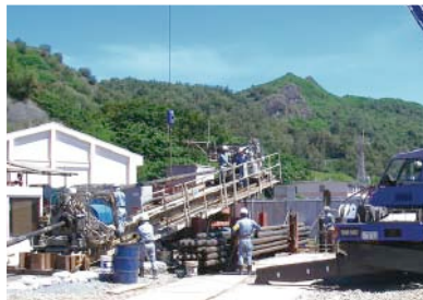
父島工事における弧状推進機
